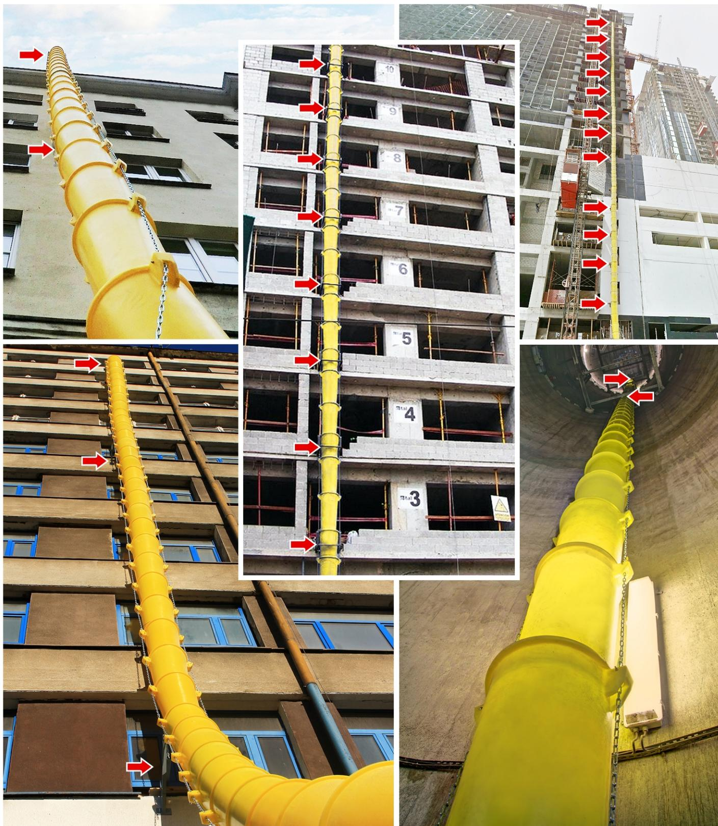
← El fabricante del bajante de escombros DROMADER recomienda por la seguridad la instalación de soporte de fijación principal y los soportes de fijación intermedios cada 15 diferentes tramos en la columna del bajante de escombros para evitar sobrecarga y posible rotura de los ganchos integrados, mosquetones o cadenas.
